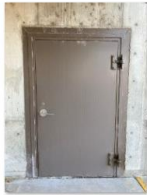
7702 Bay3 W. Annex N. Door
