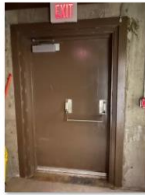
7701 Bay3 W. Annex N. Door
